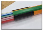
• die zusammengeklebten Streifen an den geraden Seiten des Rohrverbandes aufbringen
