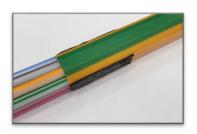
• schwarzes Butyl-Dichtband auf 2x 20mm ablängen
