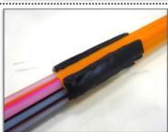
die zusammengeklebten Streifen an den geraden Seiten des Rohrverbandes aufbringen
