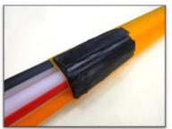
· den zusammengeklebten Streifen auf dem Rohrverband anbringen
