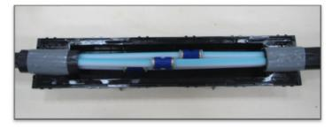
Die Rohrverbände mit dem Dichtbandaufbau in die Dichtstellen der SRV-M MAXI legen.
