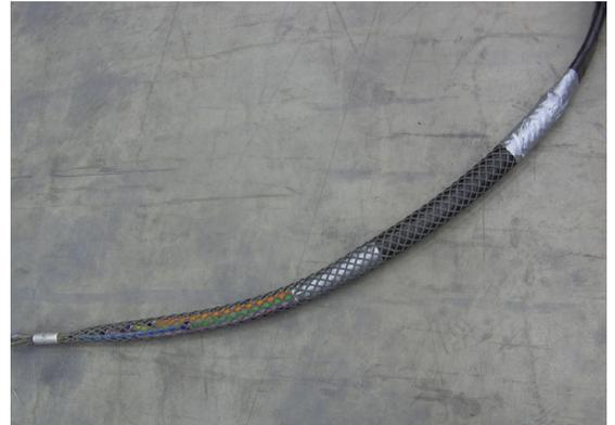
4) Ziehstrumpf (Ø 50) über das Mantelrohr des speed•pipe® Rohrverband aufschieben und mit Gewebeband fixieren (jeweils ca. 10 cm über Ziehstrumpf und Mantelrohr wickeln).
