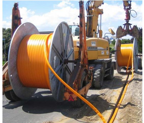
SRV-G tc eignen sich grundsätzlich für alle Micro- und Minitrenchverfahren. Jedoch gibt es bis dato keine einschlägigen Langzeiterfahrungen bzgl. Straßenschäden und die dabei entstehenden Auswirkungen auf SRV-G tc und darin befindlichen speed•pipe® ground. Wir empfehlen, die Verfahren möglichst auf gering belasteten Geh- und Fahrradwegen sowie Straßen anzuwenden.
